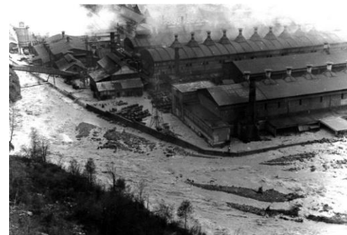
L'usine de Chedde inondée par la crue de l'Arve en septembre 1968 (crédit photo : Asso. Mémoire du Chedde)
