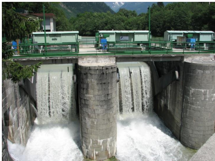
Barrage EDF des Houches sur l'Arve (crédit Photo : SM3A)
