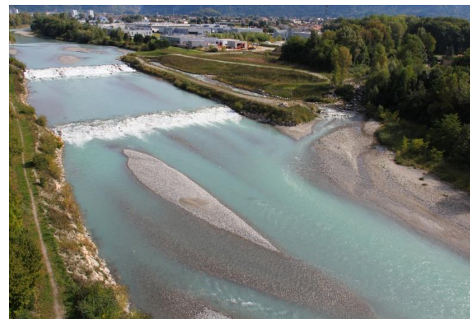
Endiguements, seuils de stabilisation et rivière piscicole de contournement sur l'Arve à Pressy (commune de Thyez) (crédit photo : SM3A)
