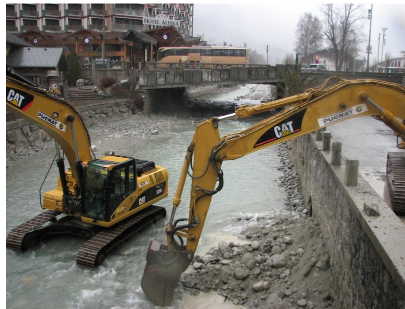
Curage de sécurité par le SM3A dans la traversée de Chamonix (Crédit Photo : SM3A)
